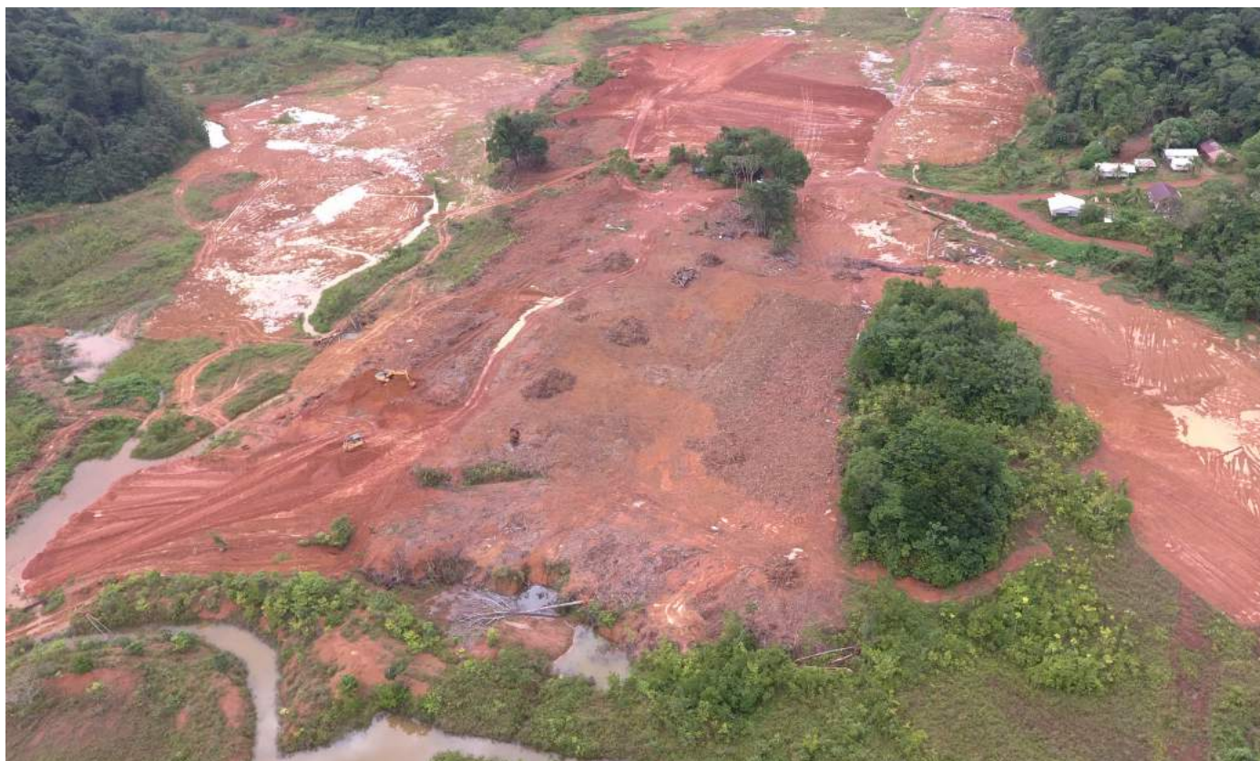
Figure 48 : Projet « VALEECO » - Zone nord – Etat d’avancement des travaux de réhabilitation au 27/11/2020
