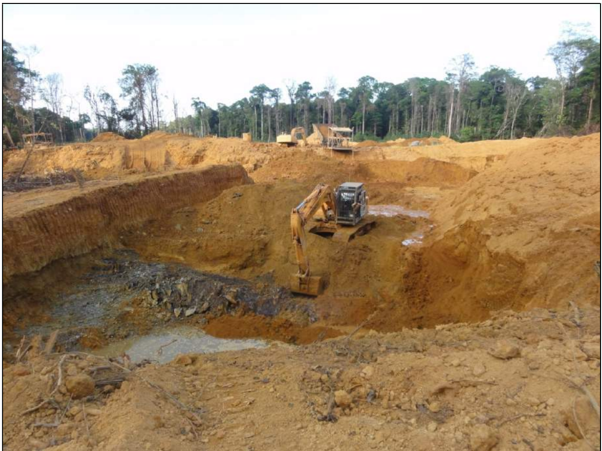
Figure 20 : Décapage et réservation des argiles stériles
