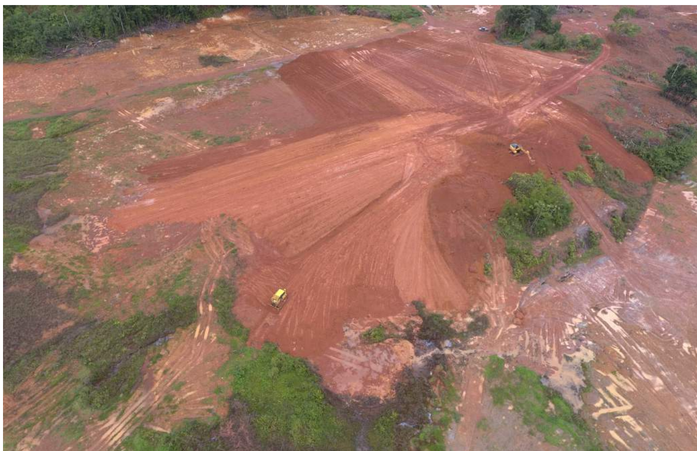
Figure 49 : Projet « VALEECO » - Zone nord – Travaux de terrassement – Prise de vue du 27/11/2020
