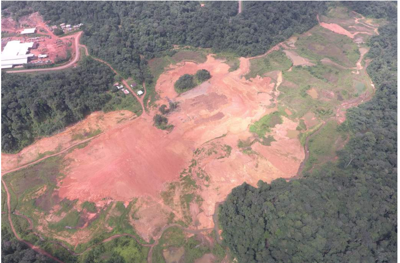
Figure 50 : Projet « VALEECO » - Zone nord – Etat d’avancement des travaux de réhabilitation au 04/03/2021
